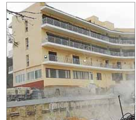
Obras en el Hostal Cala Es Pujols.
