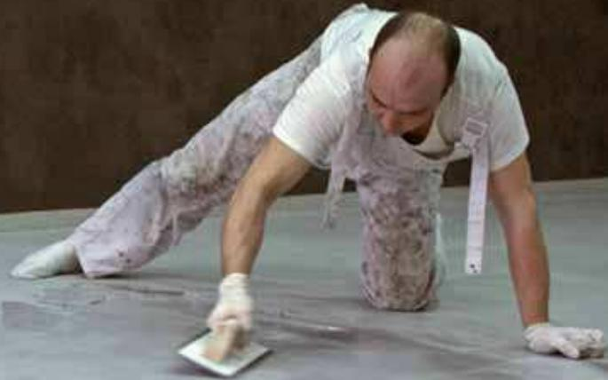
Son morteros formados por dos componentes básicos: cemento (polvo) y resina (líquido) o agua. De la mezcla de estos dos elementos resulta una pasta uniforme para revestir suelos, paredes o techos.
